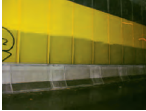
Bu tünel içerisindeki çok olumsuz koşullara rağmen, yan duvarların temizliği korozyon varlığı göstermemiştir. Fotoğraf: Centro Inox, Milan (I)
