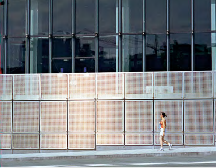
Brüksel'deki Charlemagne binası dış kaplamasında fırçalanmış ve taşlanmış delikli paslanmaz çelik levhalar başarılı bir şekilde uygulanmıştır.
