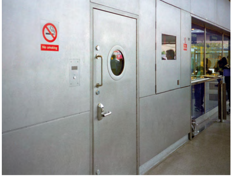
Kumlama yapılmış yüzeyler, uygulandıkları İngiltere Southwark 'daki istasyon girişlerinde başarılı bir şekilde varlıklarını sürdürmektedir.
