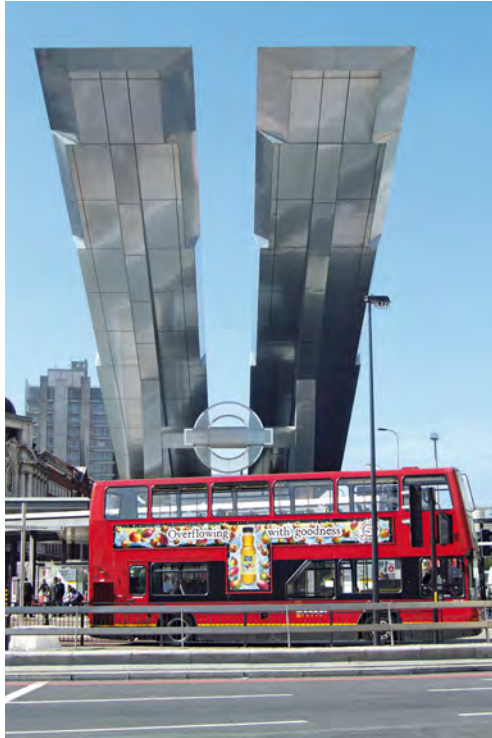
Londra'da Vauxhall Cross otobüs terminalinde, temizlik işlemlerinin en aza indirilmesi için desenli paslanmaz çelik kullanılmıştır.
