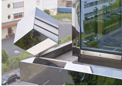
Temizlik öncesi ve sonrasında paslanmaz çelikten cephe kaplamaları. Alışlagelmiş temizlik sonucu paslanmaz çelik yüzey parlaklığının geri kazanılması. Fotoğraf: Christian Pohl GmbH Köln (Almanya)
