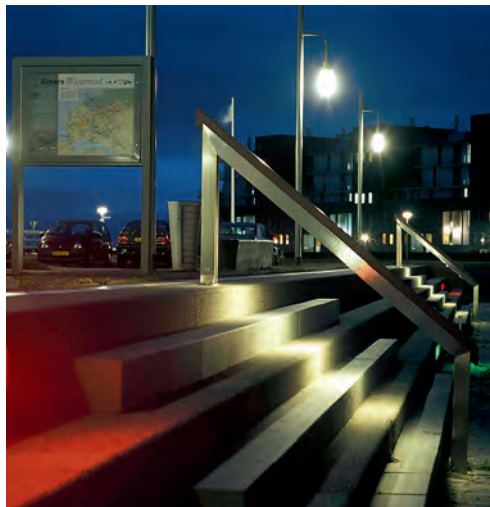
Almere limanında, ahşap merdiven küpeştesine sahip paslanmaz çelik trabzanlar su kenarına inen merdivenlere eşlik ediyor. Işıklandırma, trabzanın alt tarafına yerleştirilmiş.
