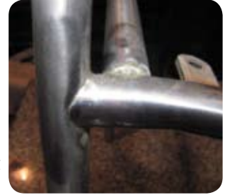
Sert lehimle kaynaklanmış borular, 441 kalite.
