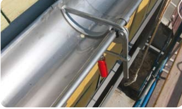
Oluk bağlaması, kalay kaplanmış 430Ti.
